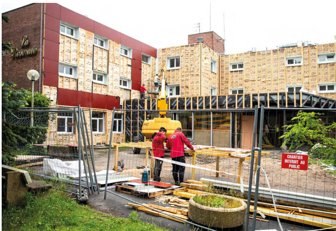
La 2 e phase des travaux a été poursuivie à l'établissement de santé La Roseraie (62).
